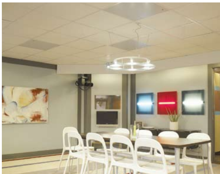
Потолочные кассеты обогревают помещение оставаясь практически незаметны. При необходимости их расположение легко изменяется.
